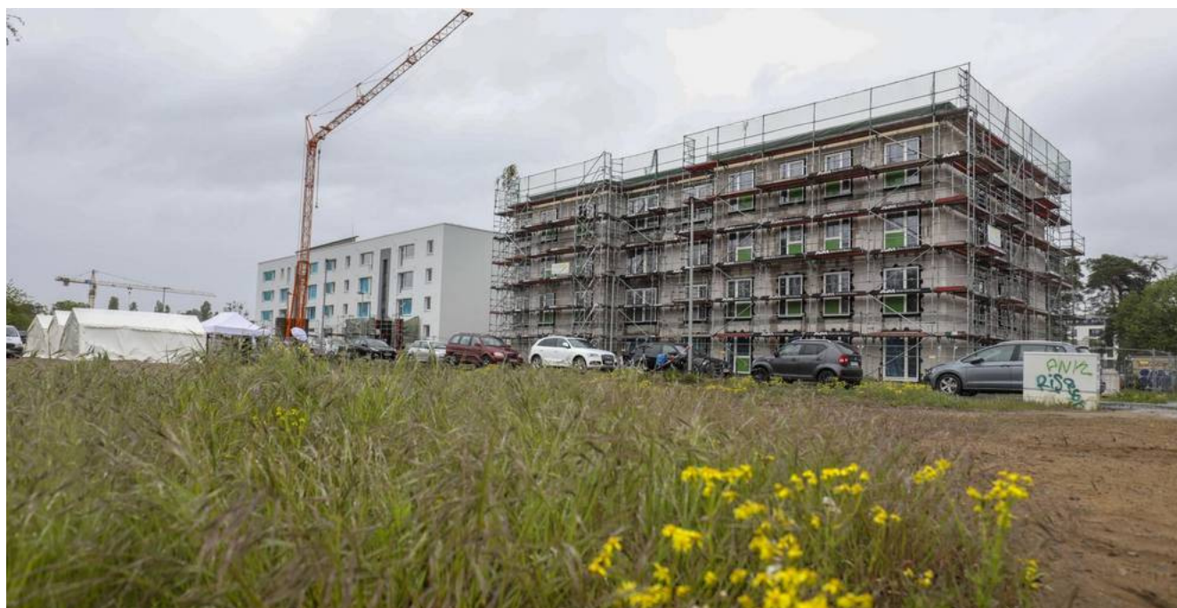
Richtfest im Neubau. In der Mahalia-Jackson-Straße entstehen 42 Sozialwohnungen in zwei Passivhäusern. (Foto: Guido Schiek)
